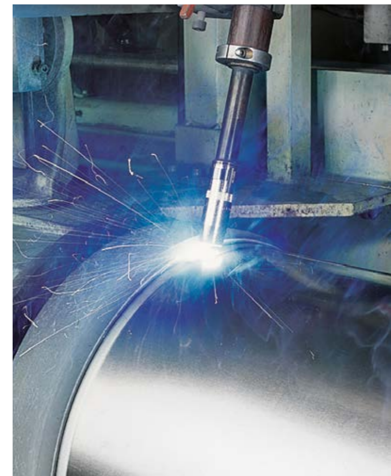
Bei diesem Druckbehälter wurden die Behälterrund- und -längsnähte mit Argon He 11® MIG-geschweißt.
