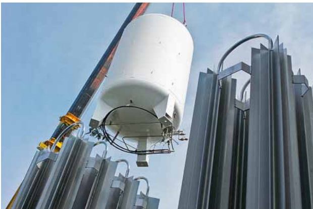
Specifieke gasvoorziening van één leverancier: Westfalen.
