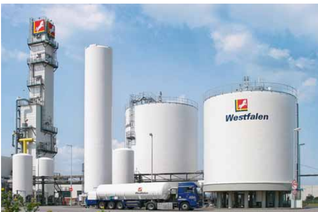
Moderne luchtsplitsingsinstallatie in Hörstel, Duitsland.
